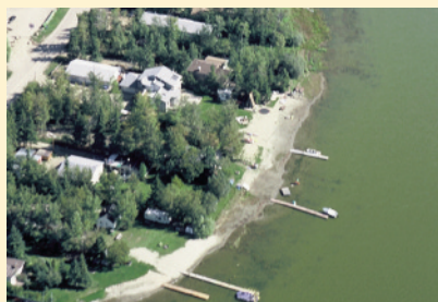
Dans cette photo, les rives exposées sont peu protégées de la glace et de l'érosion.
